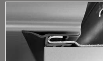
wirkungsvolle Torabdichtung zum Baukörper
